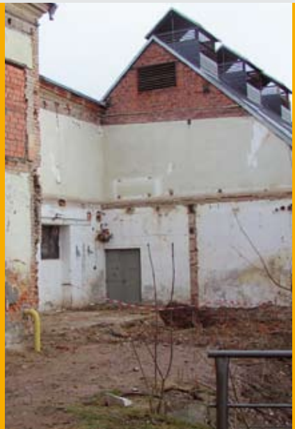
Wolllager nach dem Abriss des Anbaus
