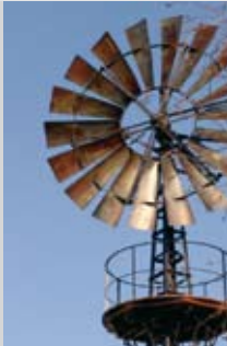
Seit Dezember dreht sich das Windrad auf dem Freigelände.
